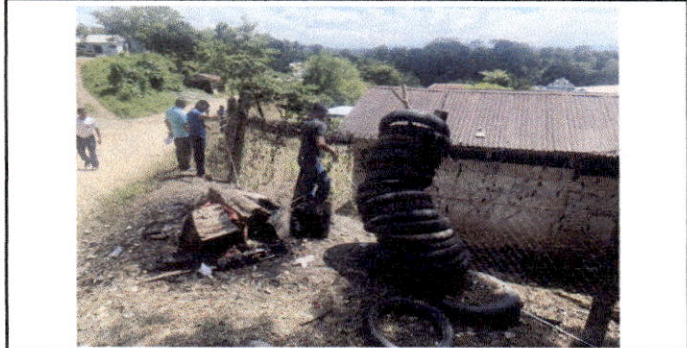
Foto 9: Malla en mal estado.
